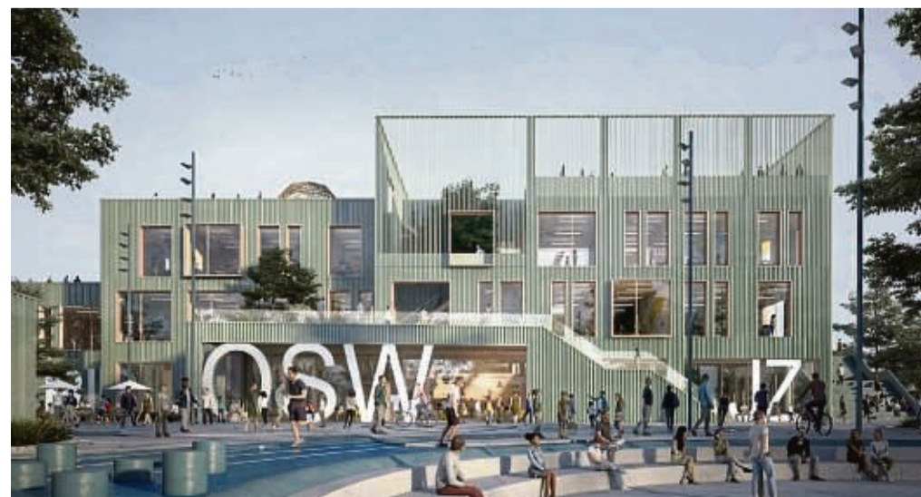
Die Offene Schule Waldau befindet sich im Moment in der Planungsphase. Unser Bild zeigt eine der Entwurfszeichnungen. FOTO: PRIVAT
