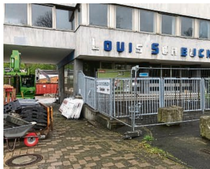
Auf der Baustelle bei Louis Scheuch finden Abrissarbeiten statt. Dort entsteht die Gesamtschule Nord+. FOTO: FABIAN DIEKMANN
